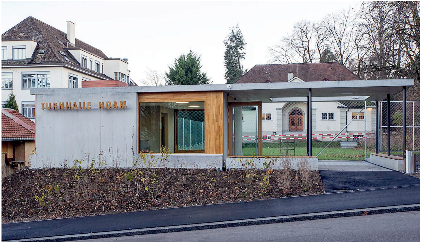
Die neue Turnhalle der NOAM, eingebettet zwischen den Schulhäusern Gabler und NOAM.
