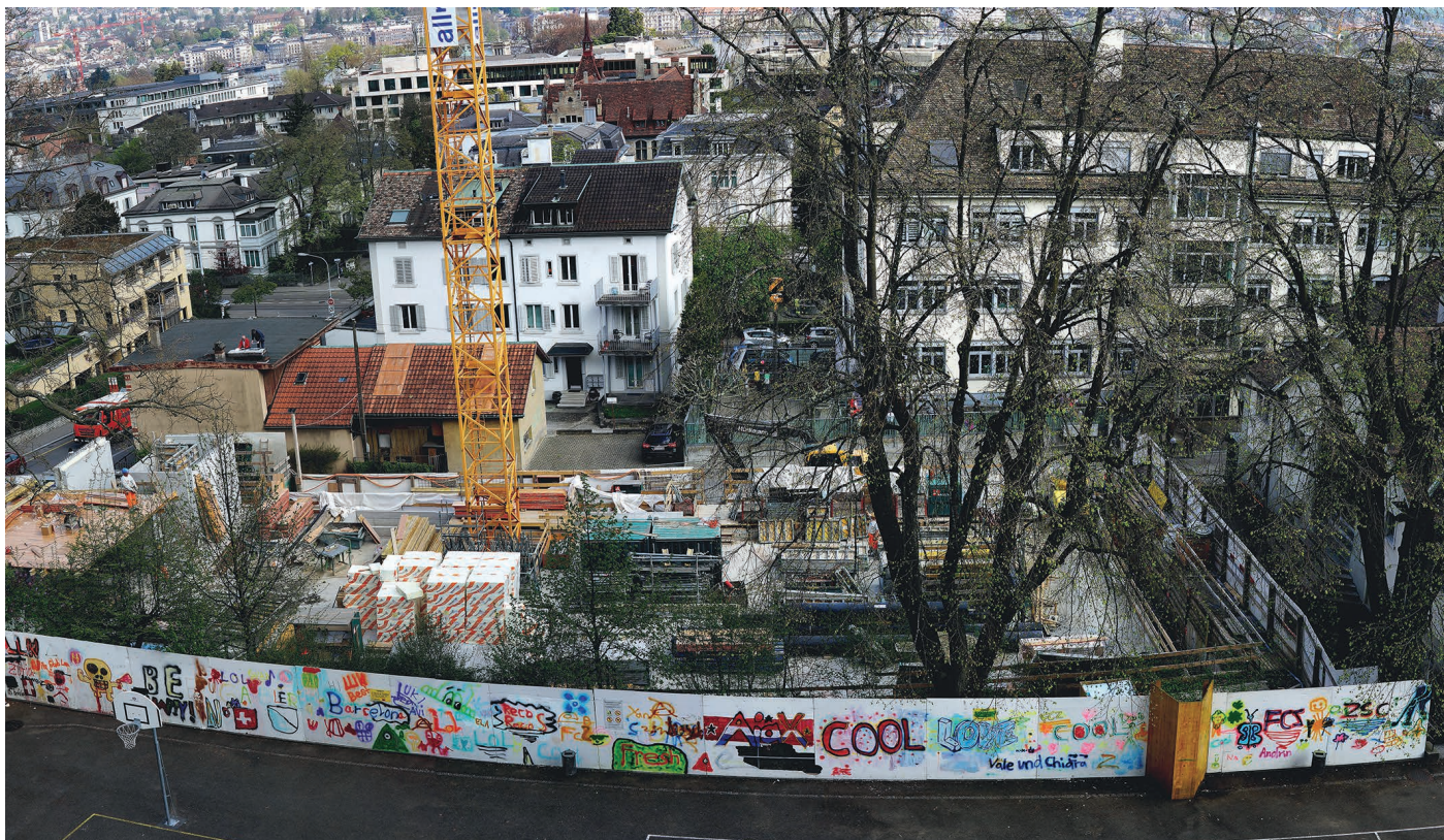
Im Bau: Die neue Turnhalle der NOAM, eingebettet zwischen den Schulhäusern Gabler und NOAM.
